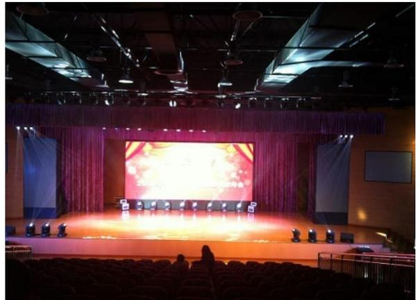
(2) 舞台上方的顶光位置配置两道灯杆，各 6 只平板柔光灯和 8 台 LED 帕灯，在满足会议照明的同时可呈现多种舞台演绎效果；
